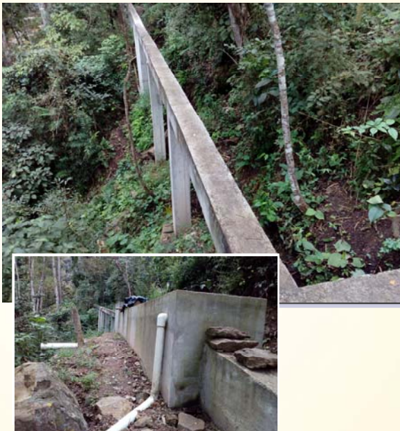
Pasos aéreos en la línea de conducción de la cosechadora de Crucita Oriente.
