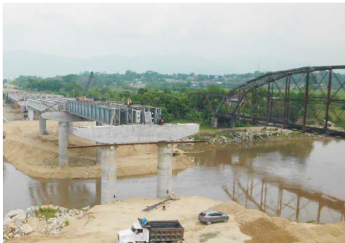
En primer plano, obras de construcción de nuevo puente a cuatro carriles, al fondo estructura de las vías del antiguo ferrocarril, entre los municipios de Potrerillos y Pimienta.
