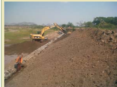
Obras de protección en Canal Los Amates, Goascorán, Valle.
