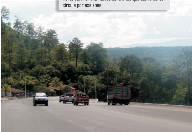
La ampliación a cuatro carriles de la Carretera CA-5 Norte permitirá la fluidez del tráfico que diariamente circula por esa zona.
