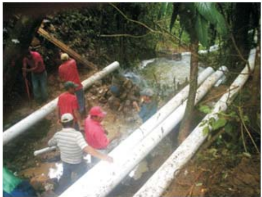
Productores cargando la tubería que forma parte del sistema de riego.
