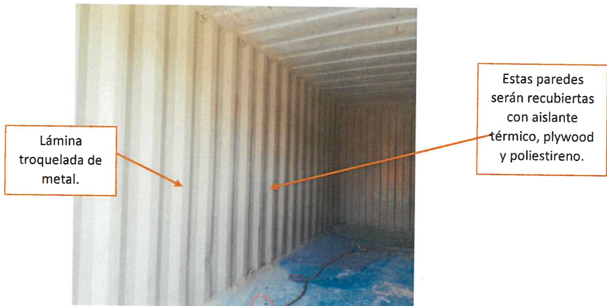
Figura 1. Fotografía detalle de construcción del contenedor.
